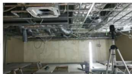
施工現場の風景
